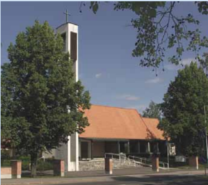
Tunnelmallinen Launeen kirkko on Lahden vanhin
