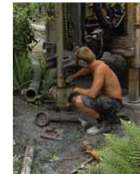
1. Borring av energibrunn
