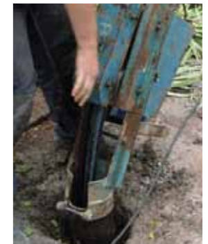
2. Kollektorns anslutning till energibrunn
