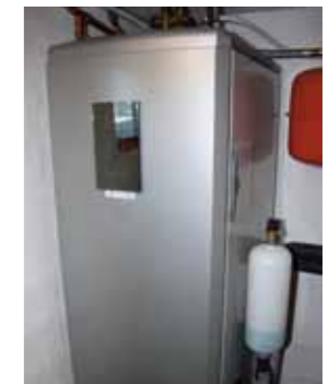
4. Värmepump installerad inomhus
